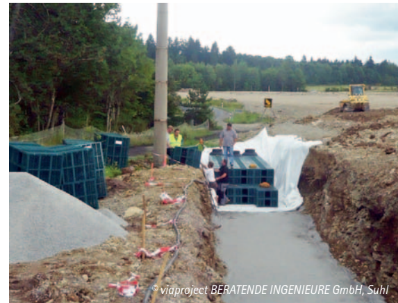
Einbau von Rigolen zur Versickerung des Oberflächenwassers
