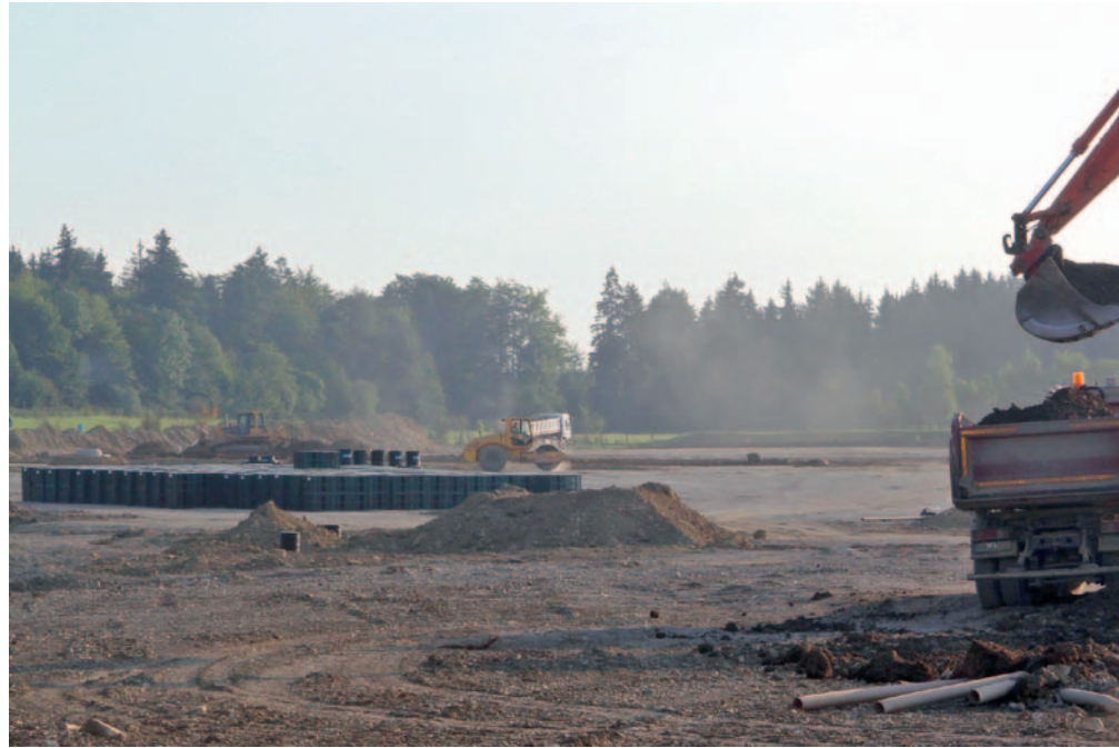
Erschließungsarbeiten im Industriegebiet Rohrer Berg
